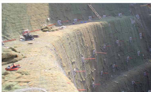
PERFORACIÓN DE MICROPILOTES
