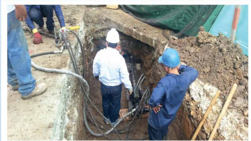
PERFORACIÓN NEUMÁTICA CON TOPO
